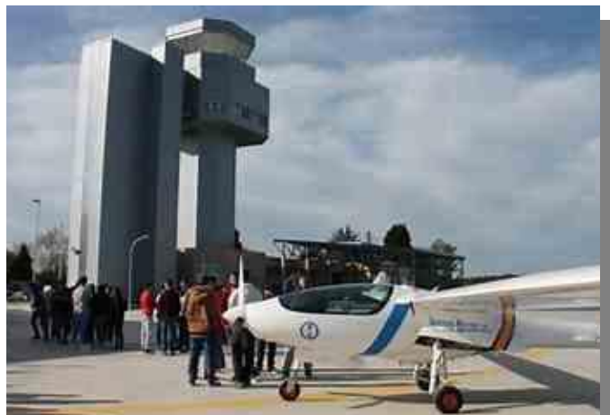
Nueva Torre de Control
