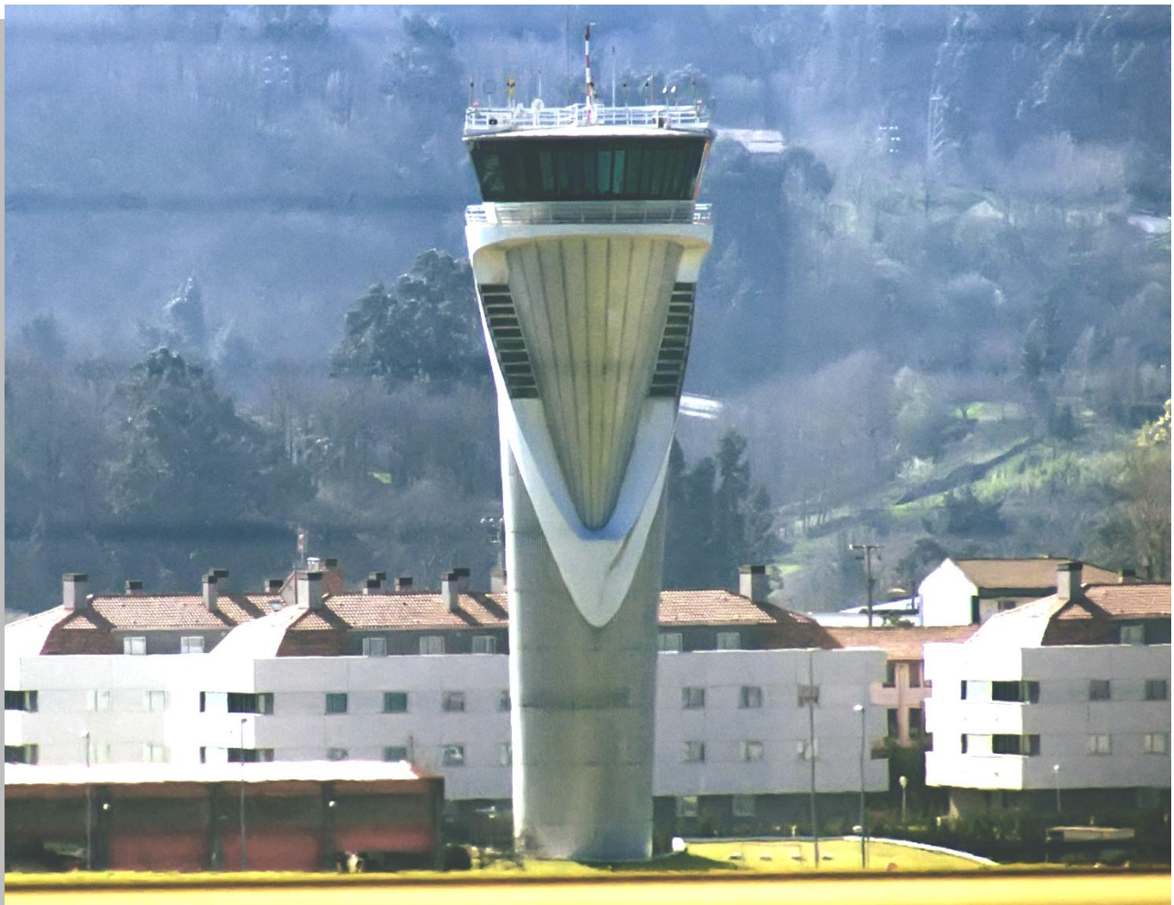
Nueva torre de control de Bilbao
